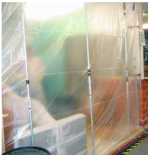
Figure 4: Séparation en zone noire et en zone blanche au moyen d'un film plastique.
